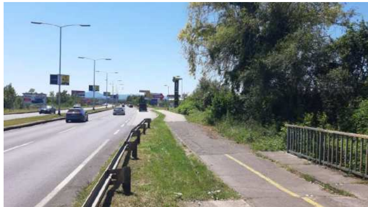
Postojeći odvojak sa Ljubljanske avenije (smjer zapad)
